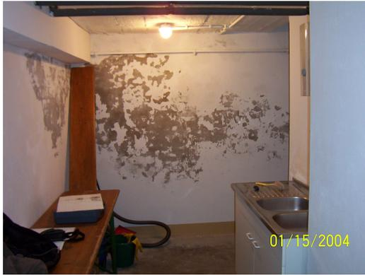
Typische Anstrichschäden, hervorgerufen durch starke Versalzung und ständig anstehende Feuchtigkeit. In diesem Fall handelte es sich bei durchgeführten Messungen über ein halbes Jahr um 14 bis 18 Gewichtsprozent Wasser. Nach herkömmlichen Methoden führt hier nur Aufgraben, der Einbau einer Drainage und das Anbringen einer funktionierenden Vertikalabdichtung zum gewünschten Erfolg.
